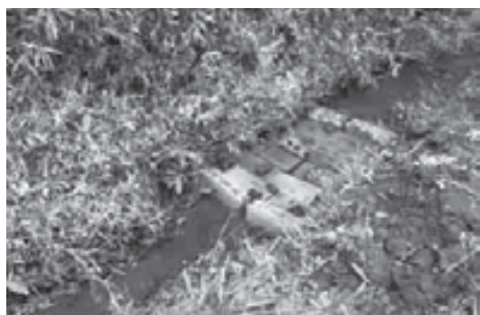
図8-3 コンクリートブロック設置後
