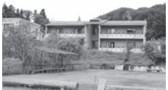
写真6 移住者向け村営住宅
