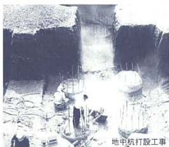
地中杭打設工事
